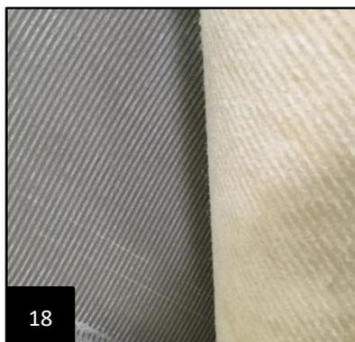
Dopodiché, ma non più tardi di 30 minuti dalla pressione manuale, sulla pavimentazione si deve passare il rullo articolato di pressione (peso almeno 50 kg) in modo omogeneo e lento (Foto 17). Controllate che l'adesivo sia distribuito omogeneamente (Foto 18) sotto tutta la pavimentazione.
